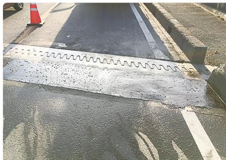
橋台背面段差解消とひび割れ抑制
