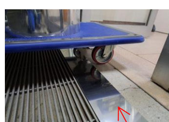
ステンレステープ施工後
