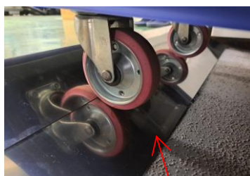
ステンレステープ施工後
