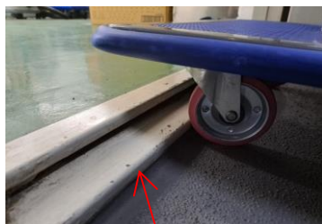
扉の段差部分 (施工前)
