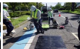
②マット敷設・加熱
