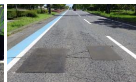
⑤施工完了
