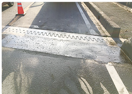
橋台背面段差解消とひび割れ抑制
