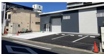
左：T1 (既存棟)
